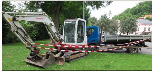
Mit diesem Minibagger haben Arbeiter aus Tschechien einen Schlitz durch den Fürstengarten gegraben. (Foto: Nopper)
